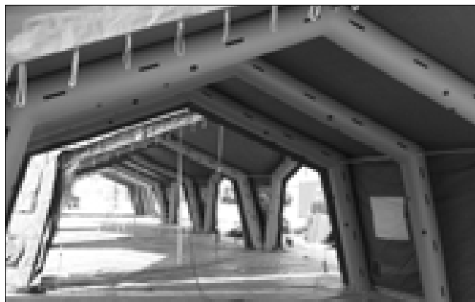
Obr. č. 2.: Pohled na rozestavěný hlavní koridor. Jsou patrné zpevňující segmenty jednotlivých dílců a boční vstupy pro připojení kontejnerových modulů.
